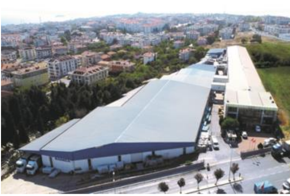
Beylikdüzü Boru Fabrikası
