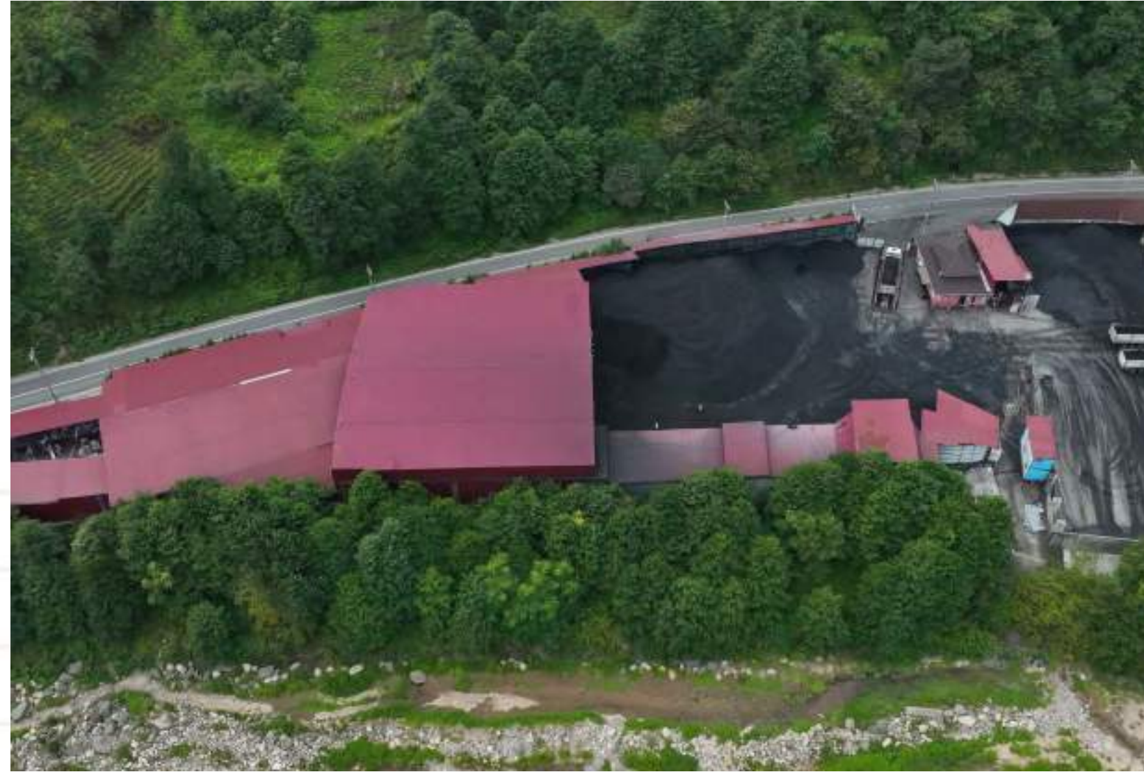
Rize Kömür Tesisi : Tesis Alanı: 8.551 m 2 Tesis Kapasite: 667 Ton/Gün
