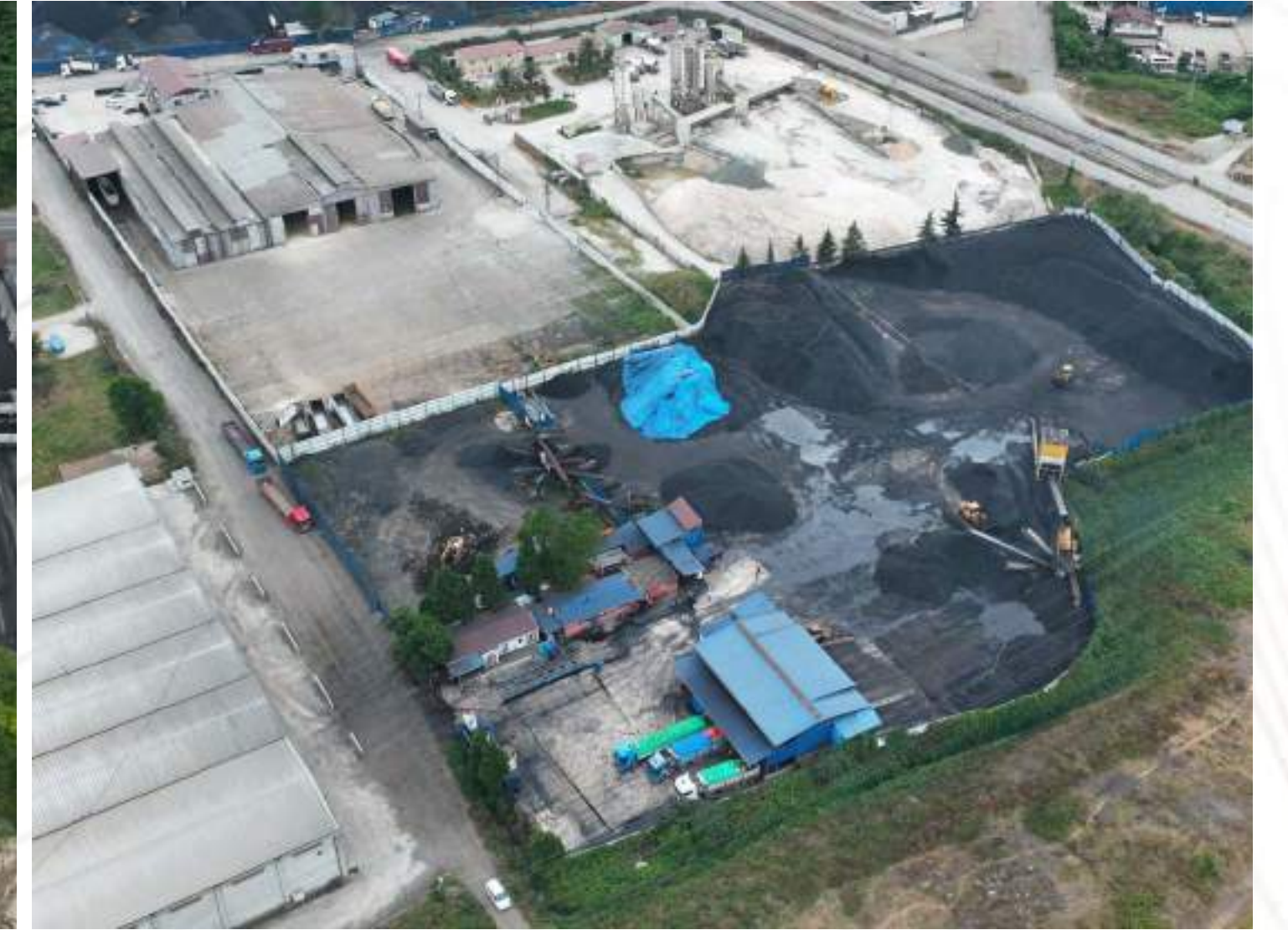
Samsun Kömür tesisi: Tesis Alanı: 14.980 m 2 Tesis Kapasite: 512 Ton/Gün
