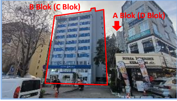
B Blok Görünümü ve Otopark Girişi (Tapu kaydında C Blok)
