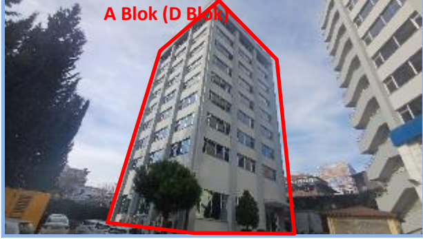
A Blok Görünümü (Tapu kaydında C Blok)
