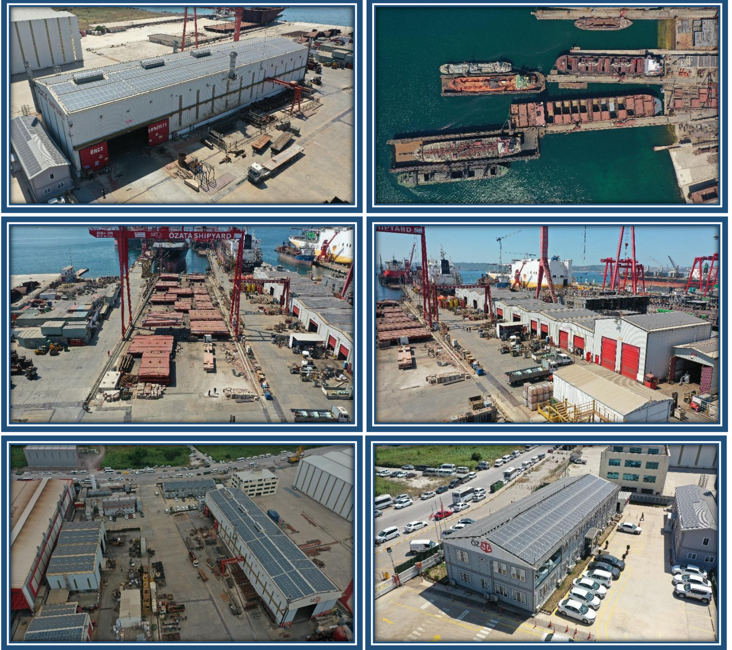
Şekil 2. Farklı Açılardan Tersane Saha Görünümü
