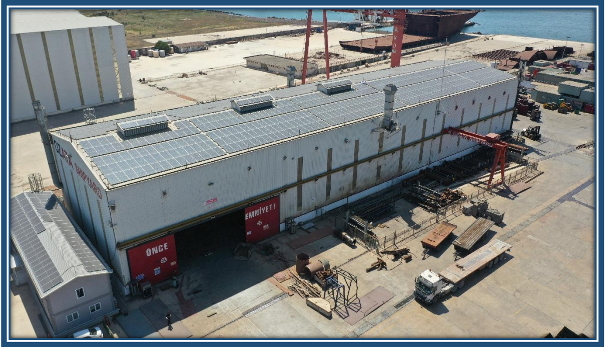
Şekil 6. Bina Üstündeki Güneş Panellerinin Görünümü
