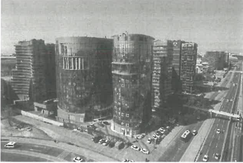
Nef 22 Ataköy: Atakö'de bulunan projede, 1+1, 2+1, 3+1 ve 4+1 olmak üzere toplam 1.454 konut ve 109 mağaza bulunmakta olup teslimi tamamlanmıştır.
