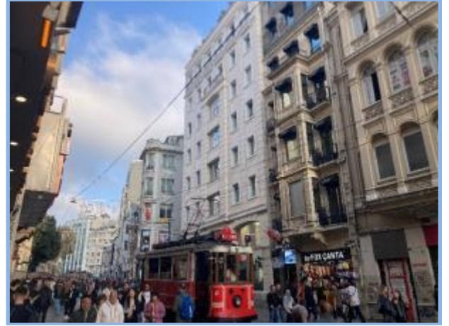
Değerlemeye Konu Bina (İstiklal Cd. Cephesi)
