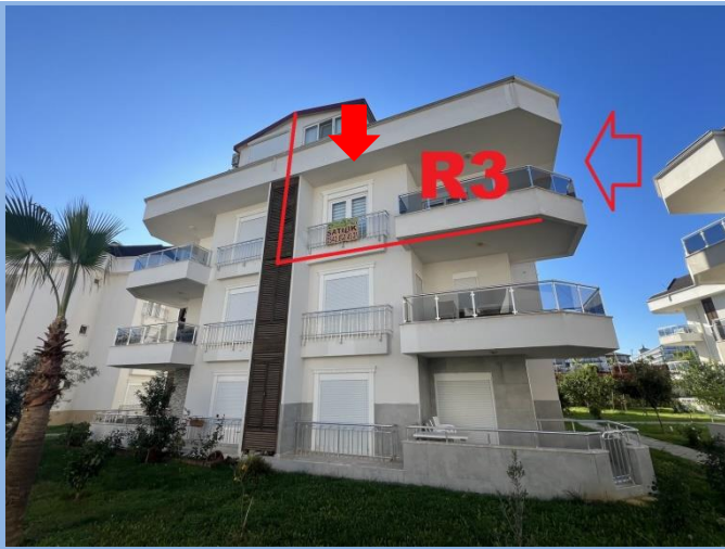
R1 Dış Cephe Görünümü
