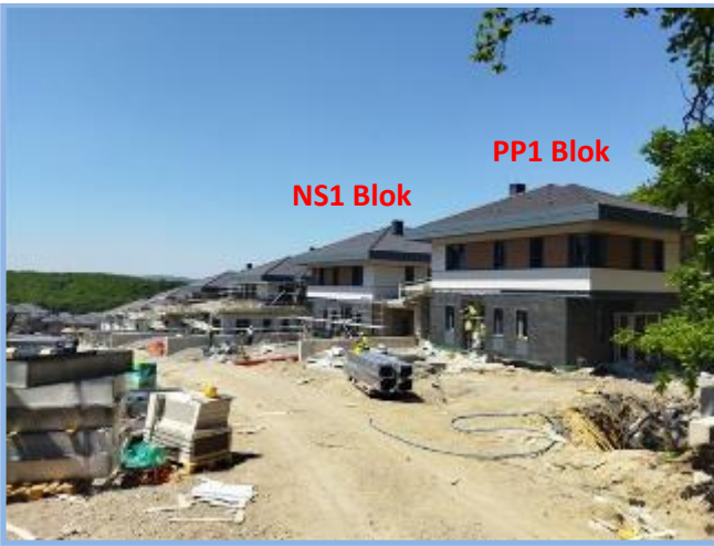
1. Etap Genel Görünüm
