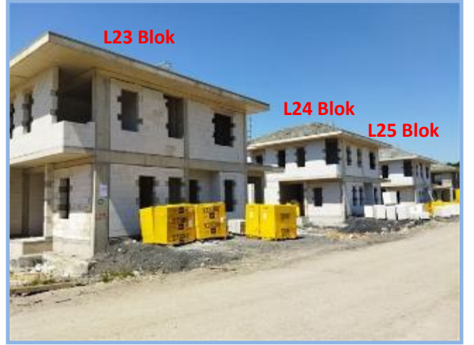
2. Etap Genel Görünüm
