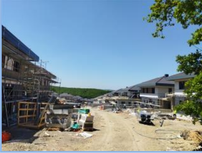
1. Etap Genel Görünüm
