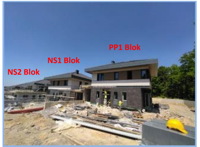
1. Etap Genel Görünüm
