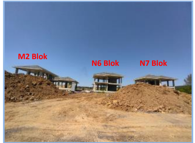
2. Etap Genel Görünüm
