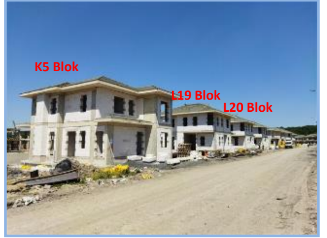
2. Etap Genel Görünüm
