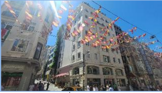
Değerlemeye Konu Bina (İstiklal Cd. Cephesi)
