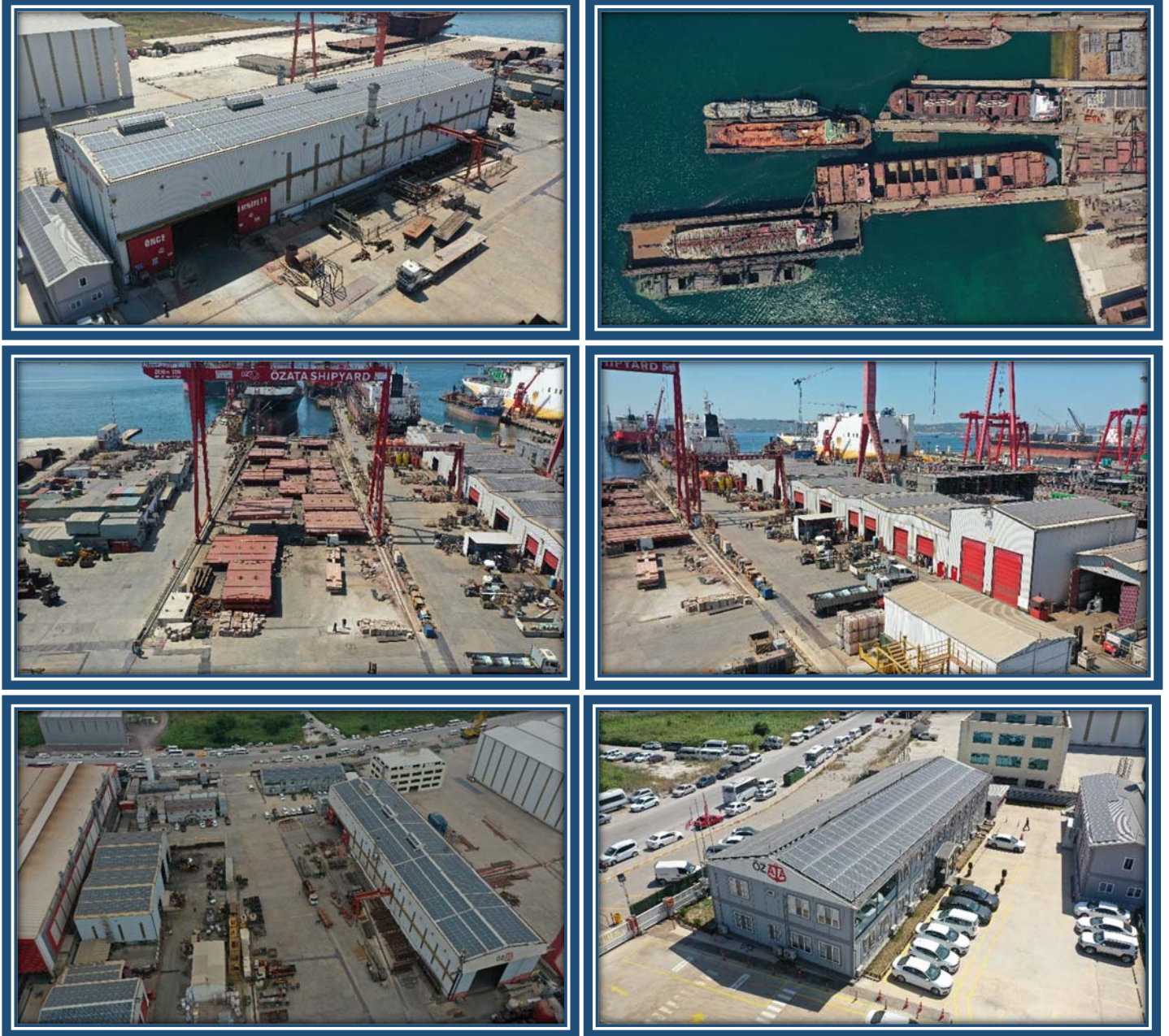
Şekil 2. Farklı Açılardan Tersane Saha Görünümü
