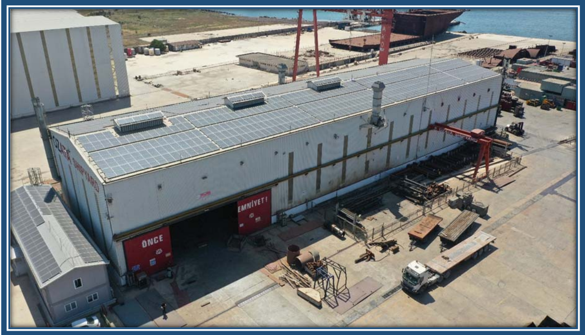
Şekil 6. Bina Üstündeki Güneş Panellerinin Görünümü
