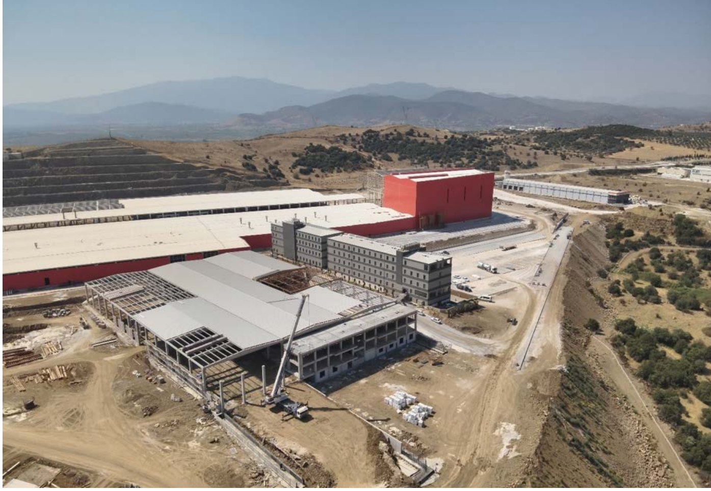
Yatırımı devam eden Çine Tesisimizde İdari Bina ve Üretim Sahası görselleri;
